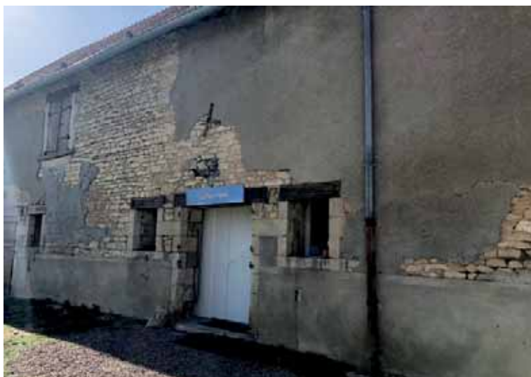
Photo 31 : Fromagerie en panneaux sandwichs dans un ancien bâtiment
