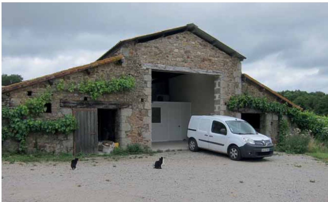
Photo 4 : La fromagerie a été installée dans une ancienne grange
