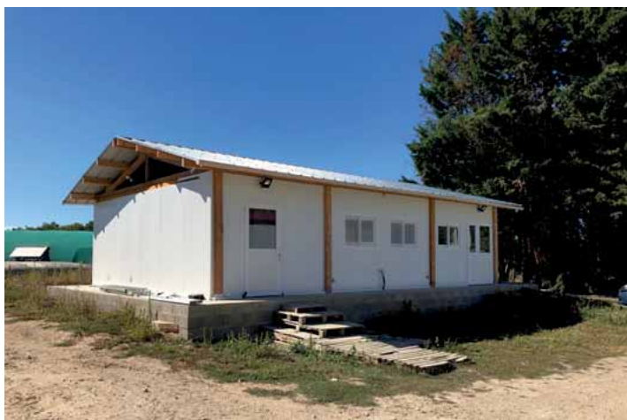
Photo 29 : Fromagerie en panneaux sandwich avant bardage bois
