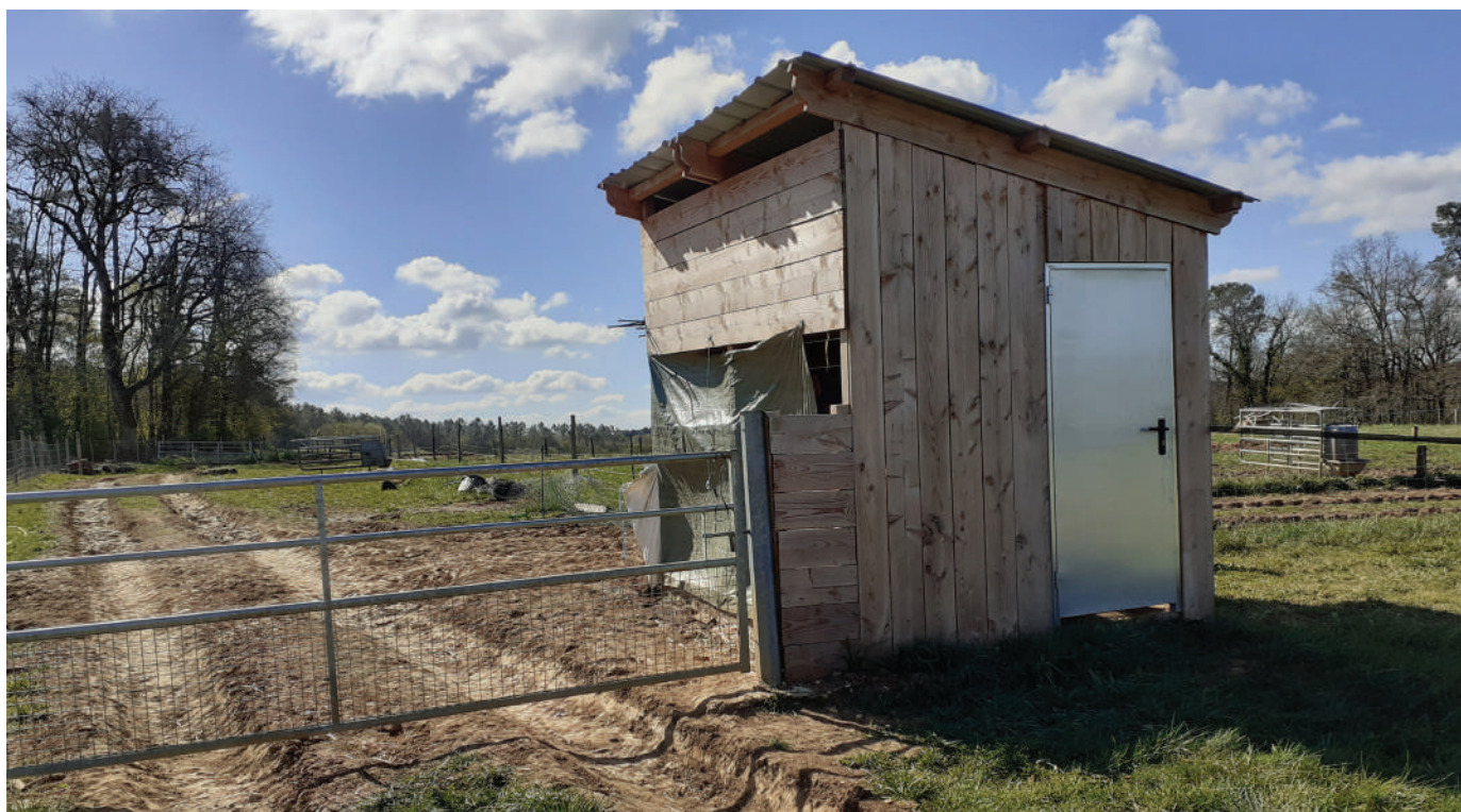
SAS sanitaire avec stockage de paille
