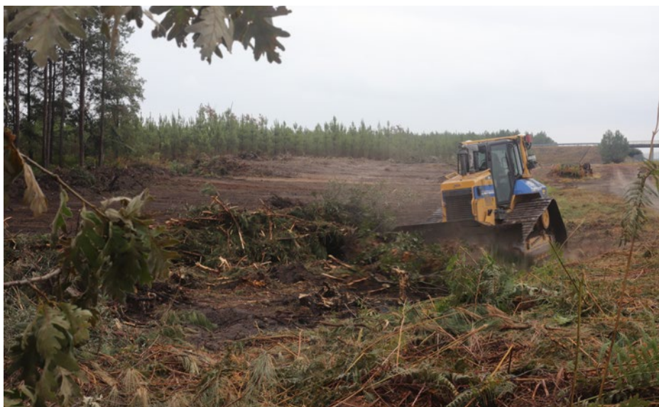
Chantier d'ouverture de pare feu
